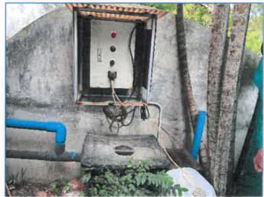
ภาพถ่ายที่ 2.2-8 ถังดักไขมันและการจ่ายสารเคมีเพื่อดักจับไขมันเบื้องต้น
