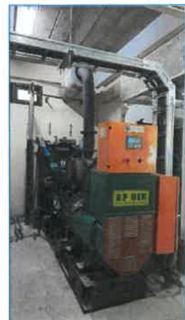
ภาพถ่ายที่ 2.2-15 เครื่องกำเนิดไฟฟ้าสำรองของโรงแรม
