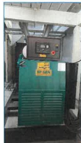
ภาพถ่ายที่ 2.2-15 เครื่องกำเนิดไฟฟ้าสำรองของโรงแรม
