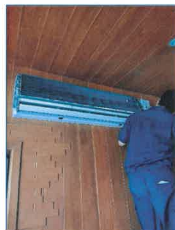
ภาพถ่ายที่ 2.2-18 เครื่องปรับอากาศและการล้างทำความสะอาด
